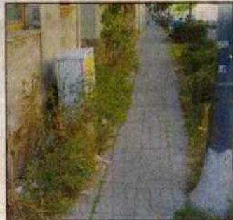
So sah es an der Zietenstraße vor der Reinigung aus.
